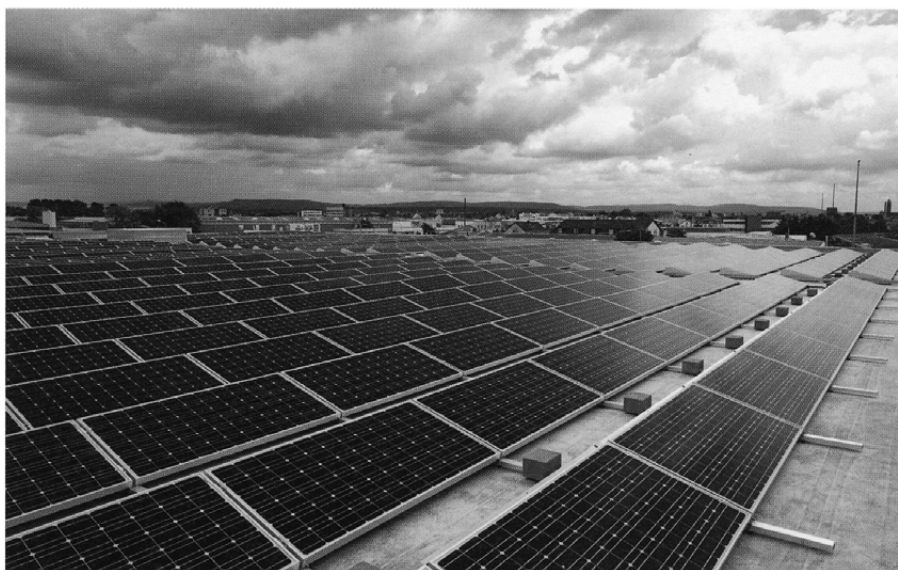
▲ Auf Nummer sicher: Das 10 000 m 2 große Flachdach wurde mit einer Flüssigabdichtung versehen, bevor die Photovoltaikanlage zum Einbau kam
