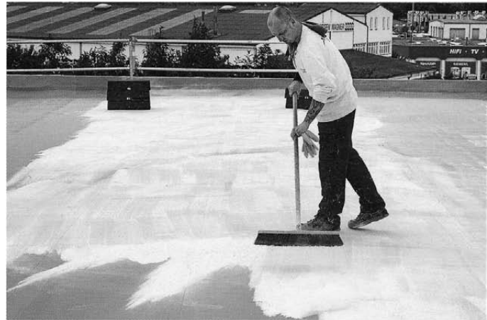
▲ Die ausreagierte Oberfläche wurde mit Talkum bestreut, um eine Restklebrigkeit auf der Abdichtung zu entfernen
