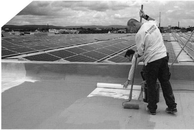
▲ Die Dachdecker haben zunächst die erste Lage aufgetragen, dann das Vlies eingebettet und mit der zweiten Lage direkt überarbeitet
